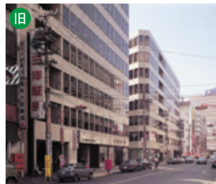
第二豊田ビル東館・西館
