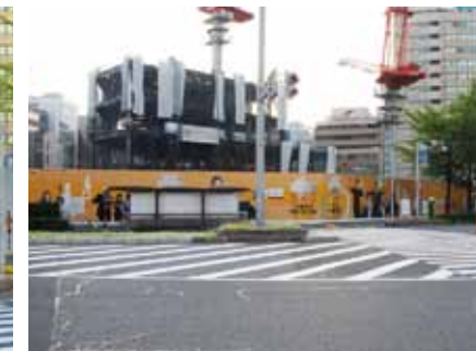
仮囲い広告(KIRIN)(7月)
